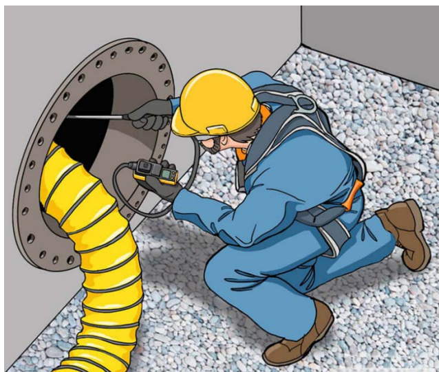
شکل ۱- ۱۴- گازسنجی برای تعیین مقدار اکسیژن و گازها و بخارات قابل اشتعال و سمی
