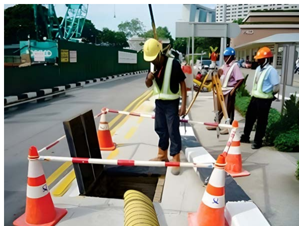
شکل ۱-۲- نمونه ایمن‌سازی معابر خارج از کارگاه در زمان انجام فعالیت ساختمانی (۲)
