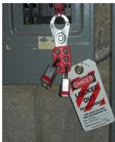
شکل ۱-۱۲- نمونه‌هایی از ابزارهای قفل گذاری / برچسب گذاری برای هشدار و محدود سازی عملکرد در مواقع نقص، تعمیر و نگهداری
