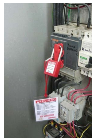
شکل ۱-۱۲- نمونه‌هایی از ابزارهای قفل گذاری / برچسب گذاری برای هشدار و محدود سازی عملکرد در مواقع نقص، تعمیر و نگهداری
