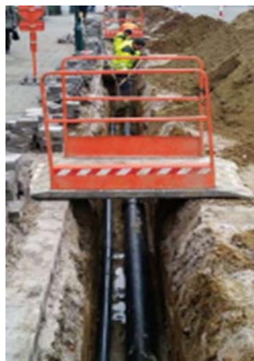
شکل ۱-۳- نمونه پل موقت (پیش ساخته) برای عبور عابر پیاده (برای تردد ایمن از محل‌های حفاری شده)
