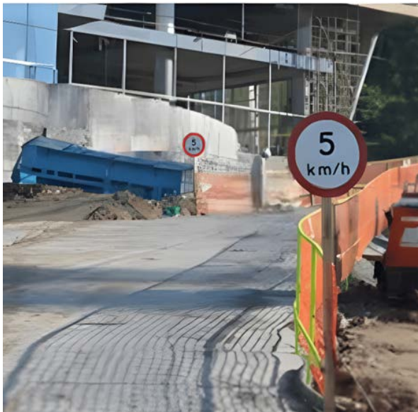
شکل ۱-۱۰- نمونه‌های مختلف طراحی و ایمن‌سازی مسیرهای تردد داخل کارگاه
