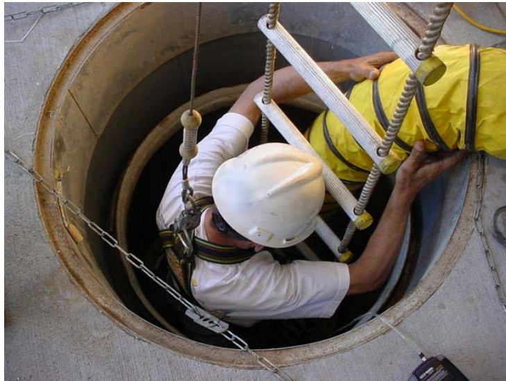
شکل ۱- ۱۵- نمونه تجهیزات هوادهی و حفاظت در برابر سقوط برای ورود به فضای بسته
