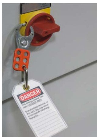
شکل ۱-۱۲- نمونه‌هایی از ابزارهای قفل گذاری / برچسب گذاری برای هشدار و محدود سازی عملکرد در مواقع نقص، تعمیر و نگهداری
