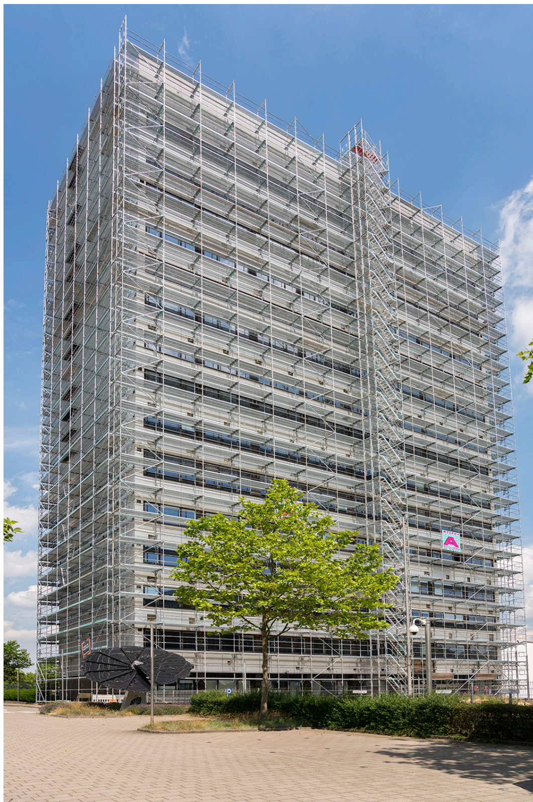
شکل ۷-۱۰- دستیابی به ارتفاع‌های بالا با داربست مدولار با پلکان دسترسی ایمن و حفظ استحکام و پایداری (بدون نیاز به کفراژبندی)
