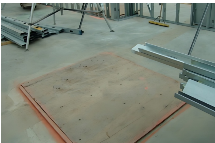
شکل ۱۰-۴- نمونه پوشش‌های حفاظتی دهانه‌های باز (بازشوها) و حفرات در کف
