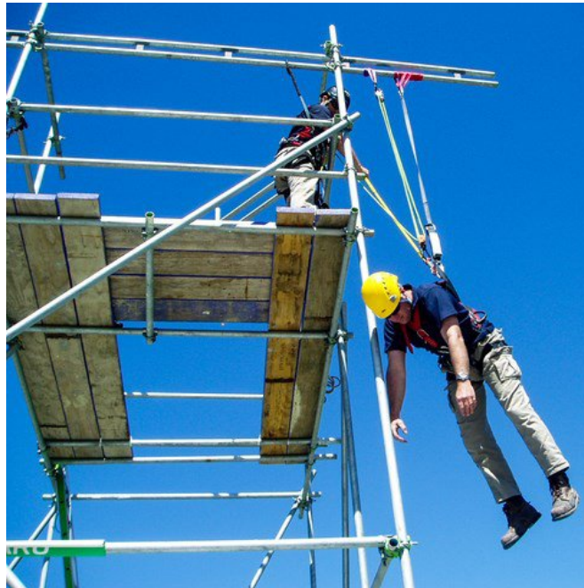
شکل ۱۰-۱۵- وضعیت فرد آویزان پس از سقوط در سامانه توقف سقوط (شرایط امکان بروز سندروم تعلیق ناشی از آویزان ماندن)
