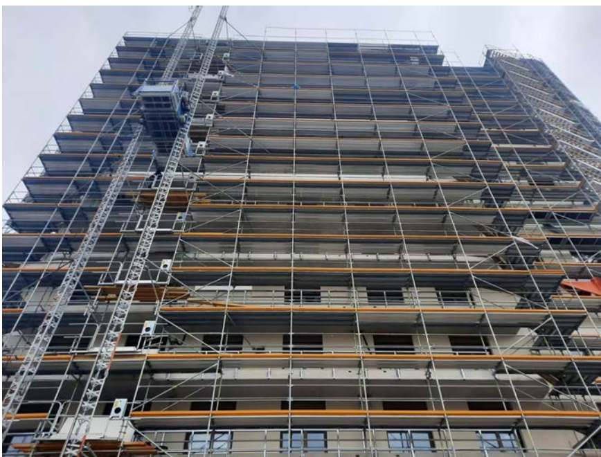
شکل ۷-۹ - انعطاف و تنوع فرم هندسی و سهولت در نصب توأمان داربست مدولار و آسانسورهای کارگاهی
