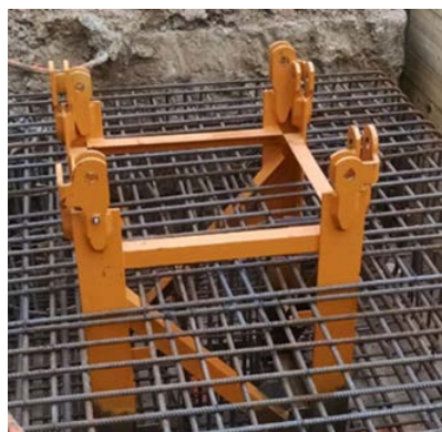
الف- پایه انکر مدفون در پی بتنی (یکبار مصرف)
