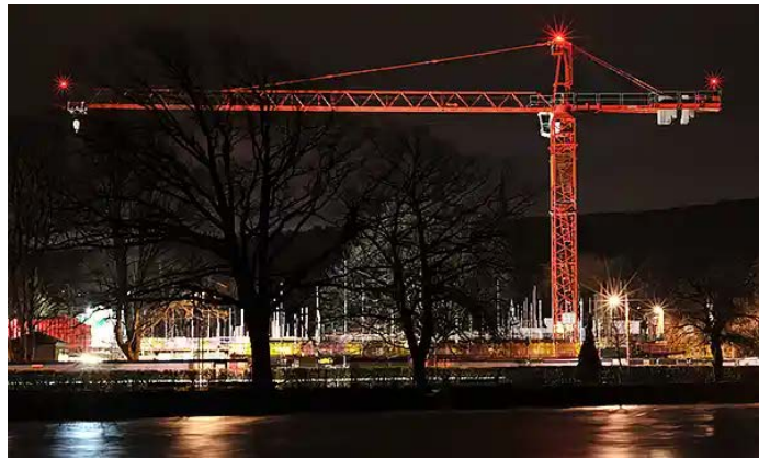
شکل ۱۵-۱۳- تامین روشنایی و نصب چراغ هشدار هوانوردی بر روی بالاترین نقطه جرثقیل برجی
