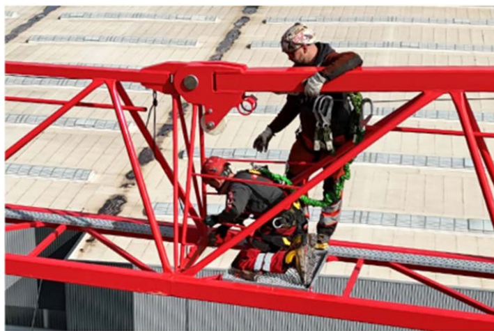
شکل ۱۵-۴- استفاده از تجهیزات حفاظت فردی توقف سقوط توسط کارکنان عملیات نصب جرثقیل برجی
