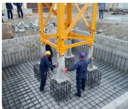
ب- پایه انکر بولت و پی بتنی (عدم دفن پایه در بتن)
