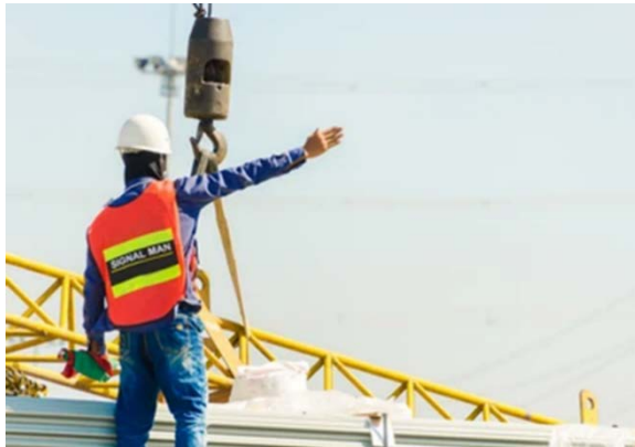
شکل ۱۵-۲۴- علامت‌دهی به اپراتور برای هدایت دقیق عملیات باربرداری
