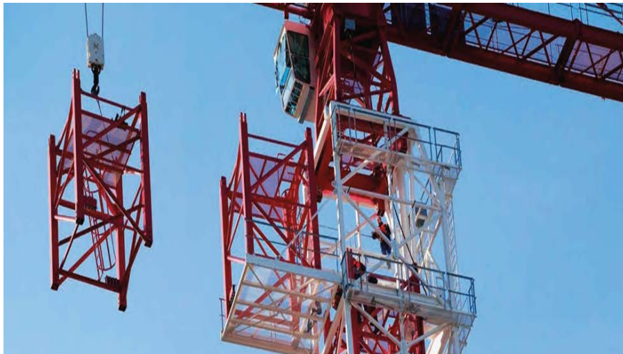
شکل ۱۵-۹- اضافه کردن قطعه به برج و افزایش ارتفاع جرثقیل برجی
