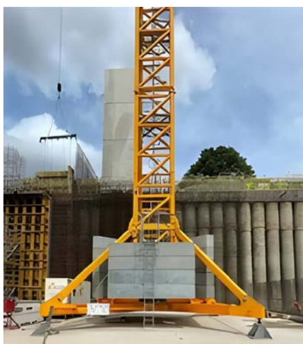
شکل ۱۵-۷- پایه فلزی ثابت با مهاربند زانویی و بالاست
