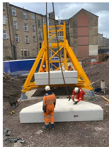
شکل ۱۵-۷- پایه فلزی ثابت با مهاربند زانویی و بالاست
