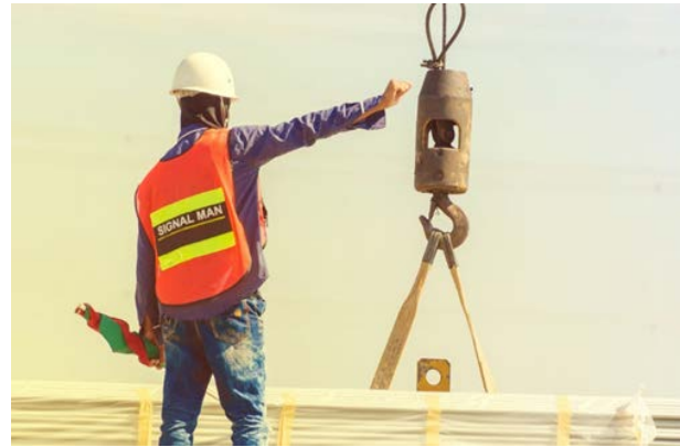
شکل ۱۵-۲۴- علامت‌دهی به اپراتور برای هدایت دقیق عملیات باربرداری
