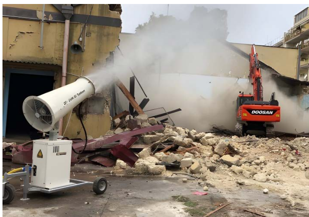
شکل ۱۹-۴- کاهش میزان انتشار گردوغبار ناشی از فعالیت های ساختمانی با استفاده از دستگاه توپ مه پاش
