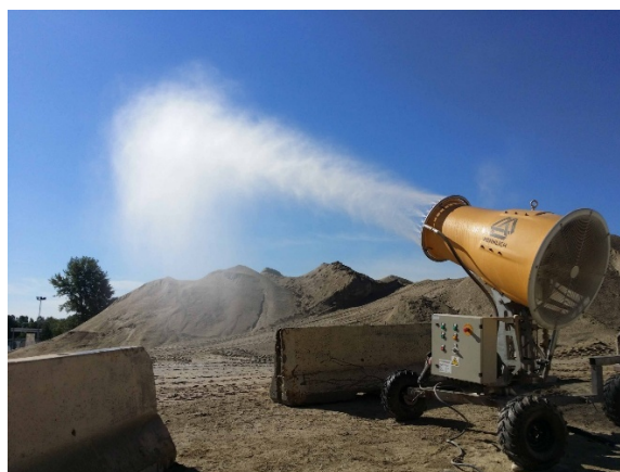
شکل ۱۹-۴- کاهش میزان انتشار گردوغبار ناشی از فعالیت های ساختمانی با استفاده از دستگاه توپ مه پاش
