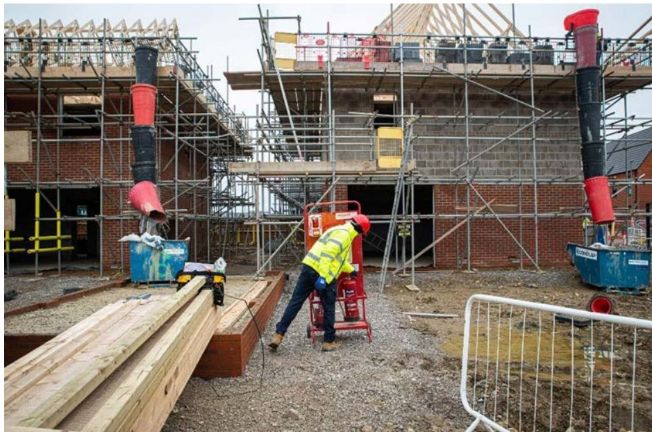
شکل ۱۹-۶- آراستگی محیط کارگاه و استفاده از شوت نخاله برای انتقال پسماند به پایین
