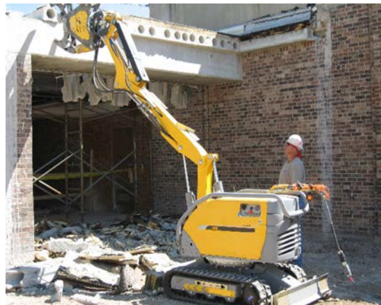
الف- دستگاه تخریب مجهز به فک خردکن بتن و جداکردن آرماتور
