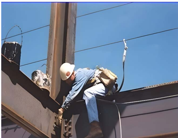
شکل ۲۷-۲- استفاده از تجهیزات توقف سقوط (لنیارد و خطوط نجات افقی)
