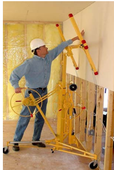
شکل ۲۸-۳- جک نگهدارنده (بالابر) صفحات (پانل‌های) گچی برای افزایش سرعت، ایمنی و کاهش عوارض اسکلتی-عضلانی
