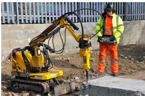
ت- دستگاه تخریب مجهز به چکش هیدرولیکی
