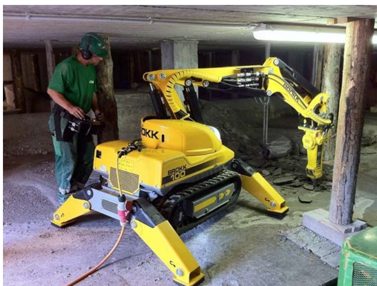
شکل ۳۵-۴- استفاده از چکش هیدرولیک رباتیک (کنترل از راه دور)
