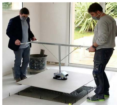
شکل ۳۰-۱- نمونه تجهیزات و ابزارهای مکانیکی ارگونومیک برای حمل و جابه‌جایی مصالح مورد استفاده در اجرای پوشش‌ها
