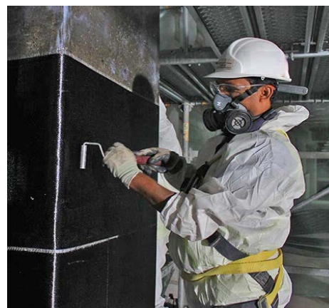
ث- انتشار بخارات رزین اپوکسی، حلال‌ها و الیاف کربن‌دار (در اثر استفاده از مواد کامپوزیت پلیمری الیافی CFRP)
