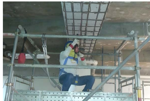
ث-پوسچر نامناسب و ثابت شانه و بازو/وضعیت نامناسب و ثابت گردن/پوسچر نامناسب لگن و زانو (چمباتمه روی داربست)
