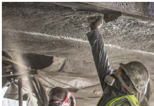
ج-پوسچر نامناسب و ثابت شانه و بازو (کار بالای سر) / وضعیت نامناسب و ثابت گردن/نیرو و فشار وارده بر دست و مچ
