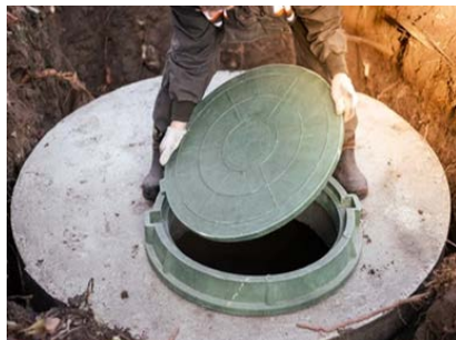
ت- نصب درپوش و ایمن سازی دهانه چاه
