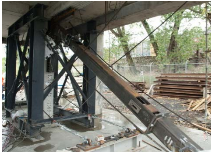
ج- نصب میراگر
