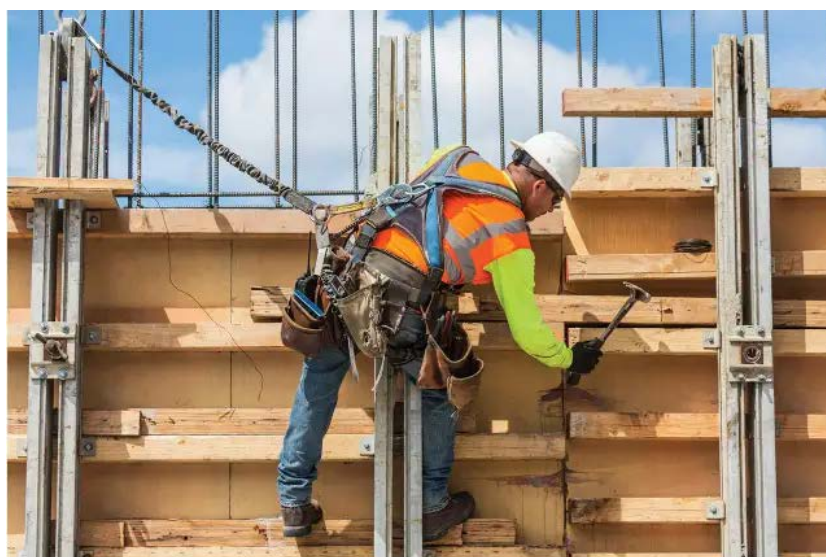
شکل ۲۶-۱- استفاده کارکنان عملیات اجرای بتن از تجهیزات توقف سقوط و تجهیزات حفاظت فردی
