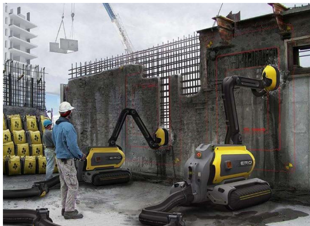
ب- ربات تخریب بتن مسلح (تخریب بتن و جمع آوری همزمان نخاله با سیستم مکش به مخزن جمع آوری با حداقل انتشار گردوغبار - تسهیل برش آرماتورها)
