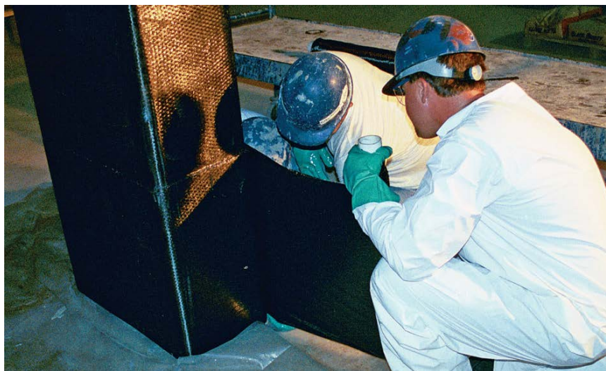
شکل ۳۵-۶- تقویت سازه‌ای با مواد کامپوزیتی پلیمری الیافی و استفاده از دستکش لاستیکی و لباس کار پوشیده توسط عوامل اجرایی
