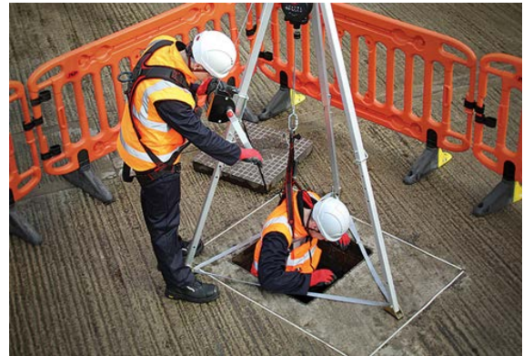
شکل ۳۴-۵- محدودسازی دسترسی به منطقه خطر با استفاده از علائم
