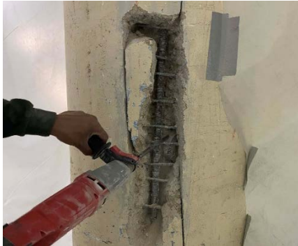
ب- تماس مستقیم دست‌ها و بازوها با لرزش شدید/ اعمال نیروی ثابت و مقابله با پس‌زدگی دستگاه/پوسچر نامناسب و ثابت تنه و گردن
