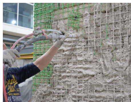
پ- انتشار گردوغبار حاوی ذرات معلق سیمان و الیاف (در اثر پاشش ملات تقویت شده کامپوزیتی)
