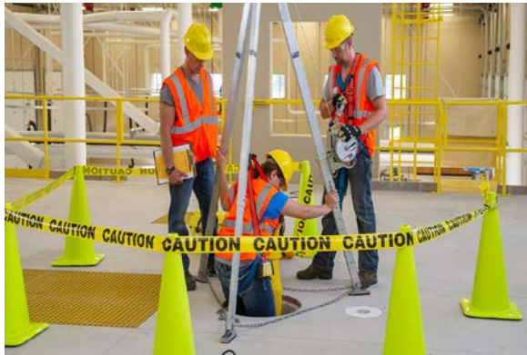
شکل ۳۴-۵- محدودسازی دسترسی به منطقه خطر با استفاده از علائم
