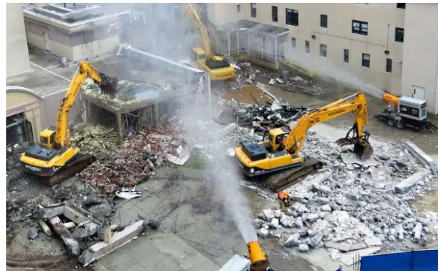
شکل ۲۴-۹- مرطوب‌سازی محیط کارگاه در حین عملیات تخریب (کاهش انتشار گردوغبار به محیط پیرامون)
