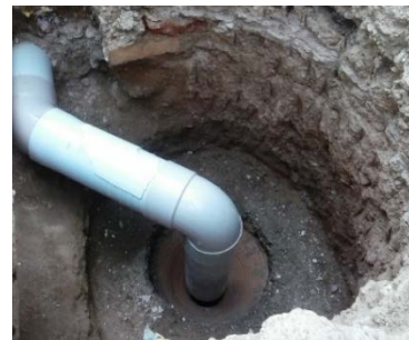
پ- اتصال لوله فاضلاب به دهانه چاه
