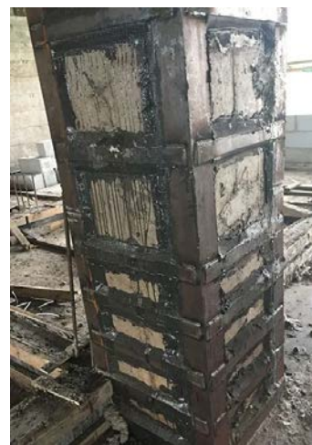
چ- بهسازی ستون بتنی (ژاکت فلزی)
