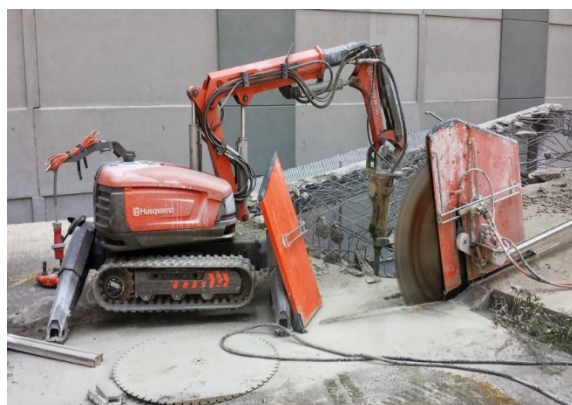
پ- دستگاه تخریب مجهز به چکش هیدرولیکی و تیغه برش
