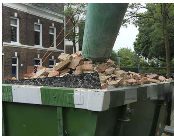
پ- نمونه مخزن قابل حمل توسط ماشین آلات حمل پسماند ساختمانی
