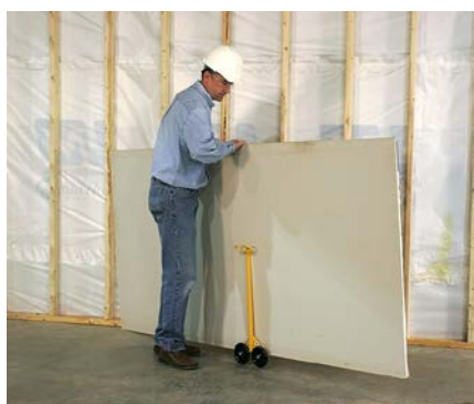
شکل ۳۰-۱- نمونه تجهیزات و ابزارهای مکانیکی ارگونومیک برای حمل و جابه‌جایی مصالح مورد استفاده در اجرای پوشش‌ها
