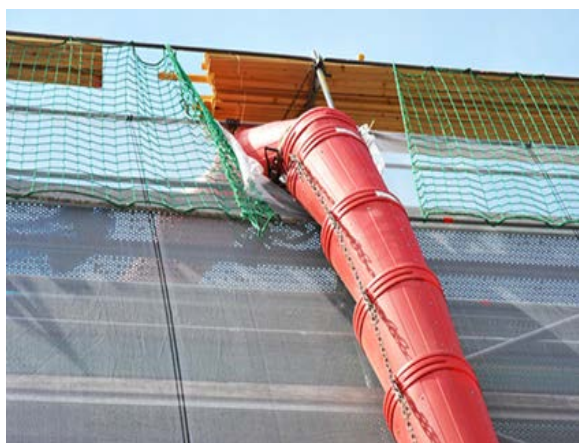
ت- ترکیب شوت تخلیه نخاله و پوشش جداره برای کنترل انتشار گردوغبار
