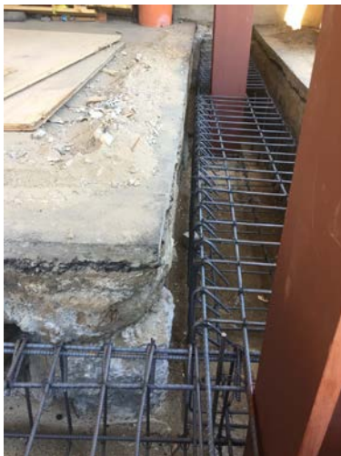
ح- تقویت فونداسیون (افزایش سطح باربری)
