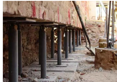
پ- تقویت فونداسیون با شمع‌های فولادی
