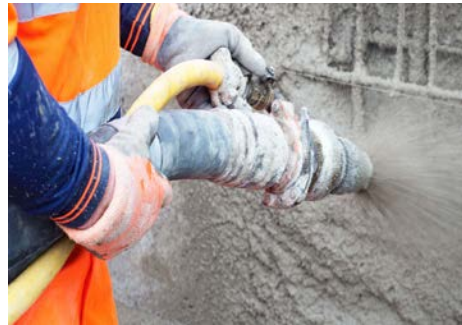
الف- اعمال نیروی زیاد و ثابت (واکنش نازل و وزن تجهیزات)/ انتقال ارتعاش شدید به دست و بازو/پوسچر نامناسب و ثابت دست‌ها و مچ
