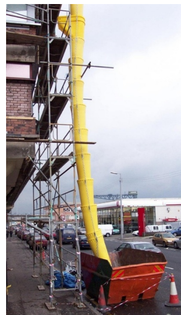
الف- شوت تخلیه و مخزن (بدون درپوش)
