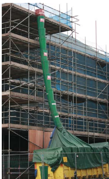
ب-شوت تخلیه (همراه با درپوش (برای کاهش انتشار گردوغبار) در زمان تخلیه در مخزن
