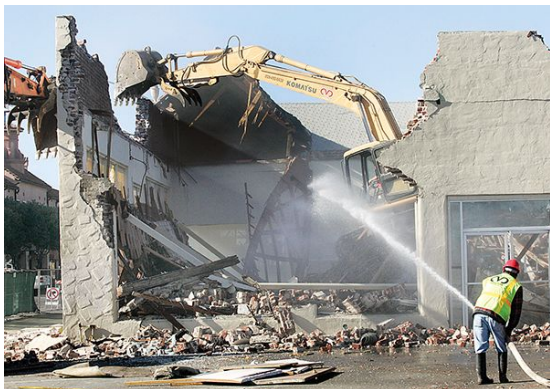
شکل ۲۴-۹- مرطوب‌سازی محیط کارگاه در حین عملیات تخریب (کاهش انتشار گردوغبار به محیط پیرامون)
