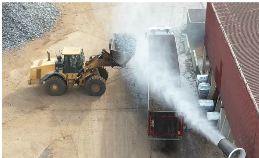
شکل ۳۵-۷- استفاده از دستگاه توپ مه‌پاش برای کنترل گردوغبار در بارگیری نخاله‌ها
