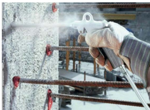
ت- انتشار گرد و غبار برخواسته از داخل گمانه‌ها (در اثر تخلیه با فشار باد قبل از کاشت میلگرد)
