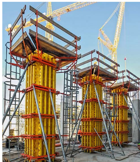
شکل ۲۶-۵- جایگاه کار ( به همراه نردبان دسترسی ایمن ) برای کارکنان عملیات اجرای اسکلت بتنی ( جایگاه کار ستون )
