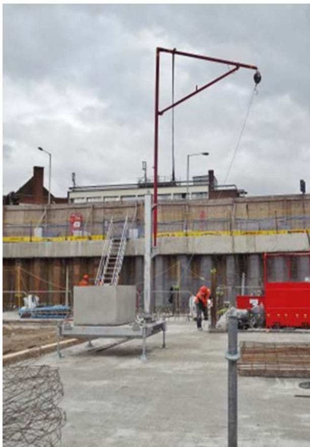
سیستم‌های سازه‌ای تکیه‌گاه مهار (تثبیت پایه با قطعه بتنی پیش‌ساخته)
