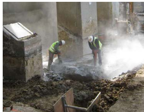
الف- انتشار گردوغبار حاوی ذرات معلق سیلیس/سیمان (در اثر عملیات تخریب)
