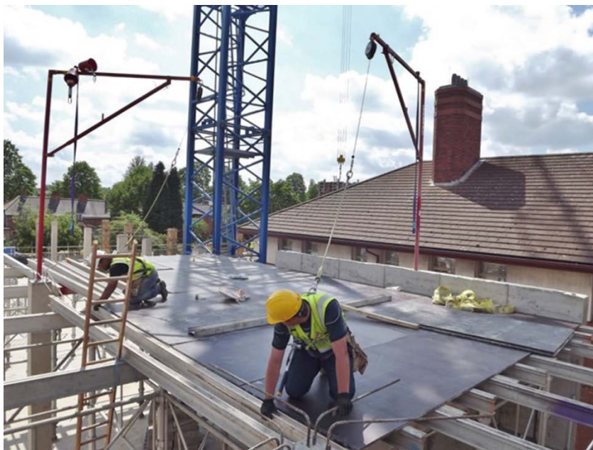
استفاده فرد قالب‌بند از تجهیزات توقف سقوط (اتصال به تکیه‌گاه و خط نجات خود جمع‌شونده)
