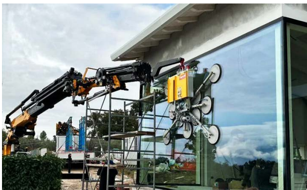
شکل ۳۱-۵- جابه‌جایی و نصب پانل‌های نما با استفاده از تجهیزات مکانیزه (دستگاه‌های مکنده خلأ)
