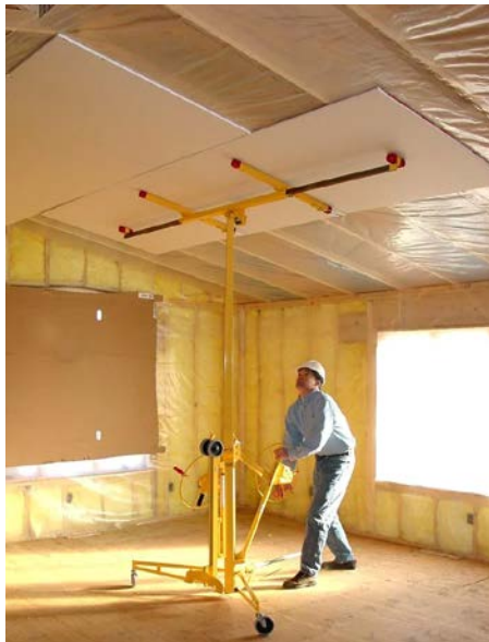
شکل ۲۸-۳- جک نگهدارنده (بالابر) صفحات (پانل‌های) گچی برای افزایش سرعت، ایمنی و کاهش عوارض اسکلتی-عضلانی
