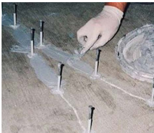
ج- انتشار بخارات سمی و ذرات معلق شیمیایی (در اثر تزریق رزین یا اپوکسی به ترک‌های سطح بتنی)
