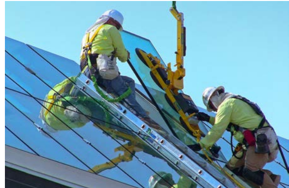
شکل ۳۱-۵- جابه‌جایی و نصب پانل‌های نما با استفاده از تجهیزات مکانیزه (دستگاه‌های مکنده خلأ)
