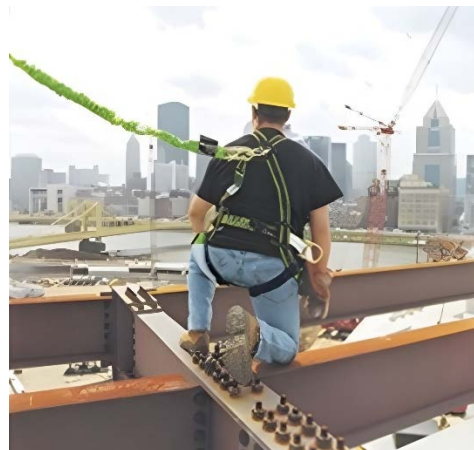
شکل ۲۷-۲- استفاده از تجهیزات توقف سقوط (لنیارد و خطوط نجات افقی)
